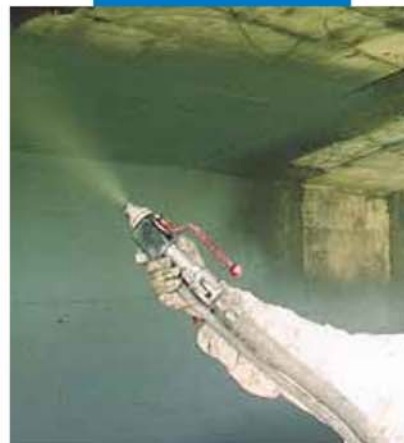
Нанесение Mapelastic на виадук распылением
