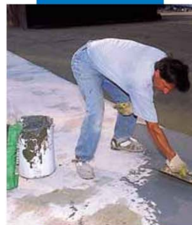
Гидроизоляция плавательного бассейна с помощью Mapelastic
