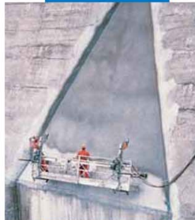
Нанесение Mapelastic на дамбу распылением
