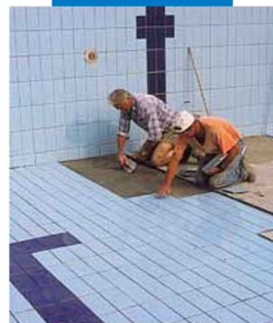
Укладка керамической плитки на Mapelastic в плавательном бассейне
