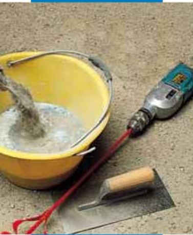
Замешивание Mapelastic миксером
