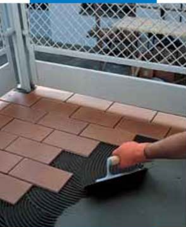
Укладка плитки на клей Graniprid на балконе, гидроизолированном с помощью Mapelastic
